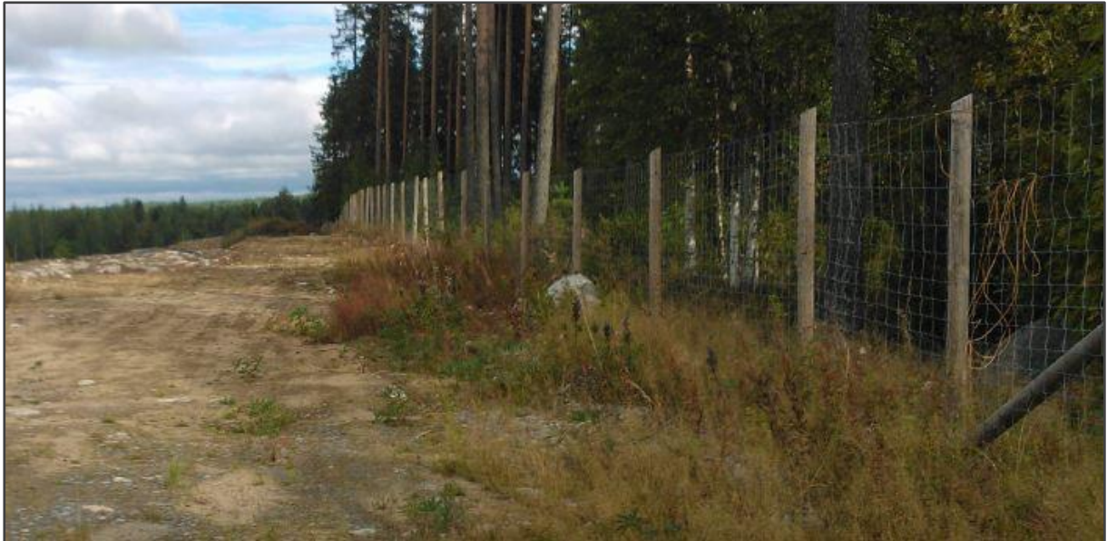
Kuva 14. Itäpuolen kallioseinämän kiertävä aita
