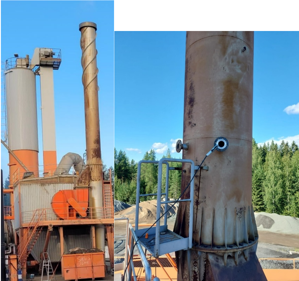
Kuva 1. Siilinjärven asfalttiaseman pääpiippu ja mittausyhteet.
