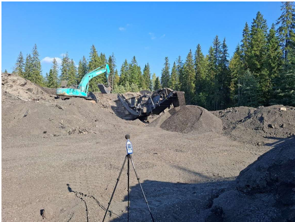
Kuva 1. Asfaltin murskaus ja referenssiäänitasomittari.
