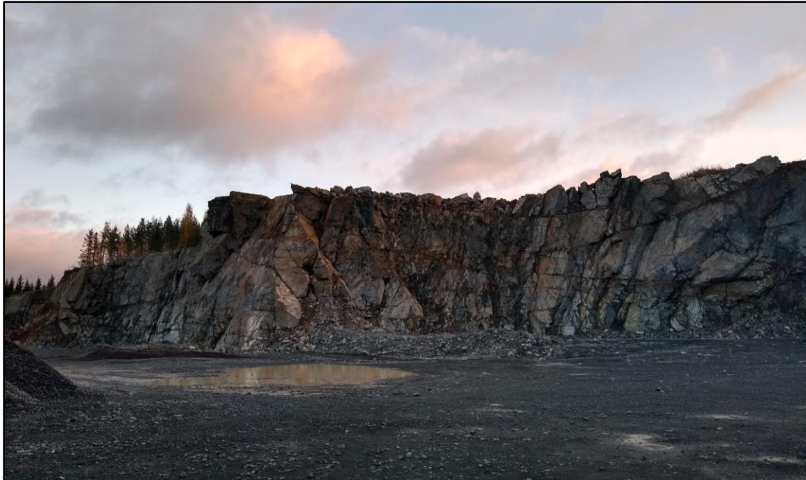
Kuva 12. Arpalahti ottoalueen nykytilannetta, kuva ottoalueen pohjatasolta pohjoisen suuntaan [15]
