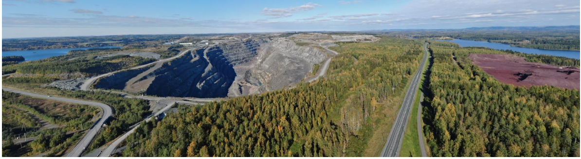
Kuva 2.11. Viistoilmakuva Yaran tehdas- ja kaivosalueelta kesällä 2022. Kuva on otettu kaivosalueen eteläosan läheisyydestä Nilsiantien kohdalta. Näkymä on pohjoisen suuntaan. Etualalla vasemmalla Nilsiantien pohjoispuolella näkyy Särkijärven louhos ja Nilsiantien eteläpuolella, kuvassa oikealla, näkyy rikkihappotuo- tannosta sivuvirtana syntyvän pasutteen läjitysalue (punaruskea alue). Taustalla, Särkijärven louhoksen takaoikealla, näkyy Itäläjäytys. Kuuslahti näkyy kuvan oikeassa laidassa ja Sulkavanjärvi vasemmalla. (Yara Suomi Oy 2024)
