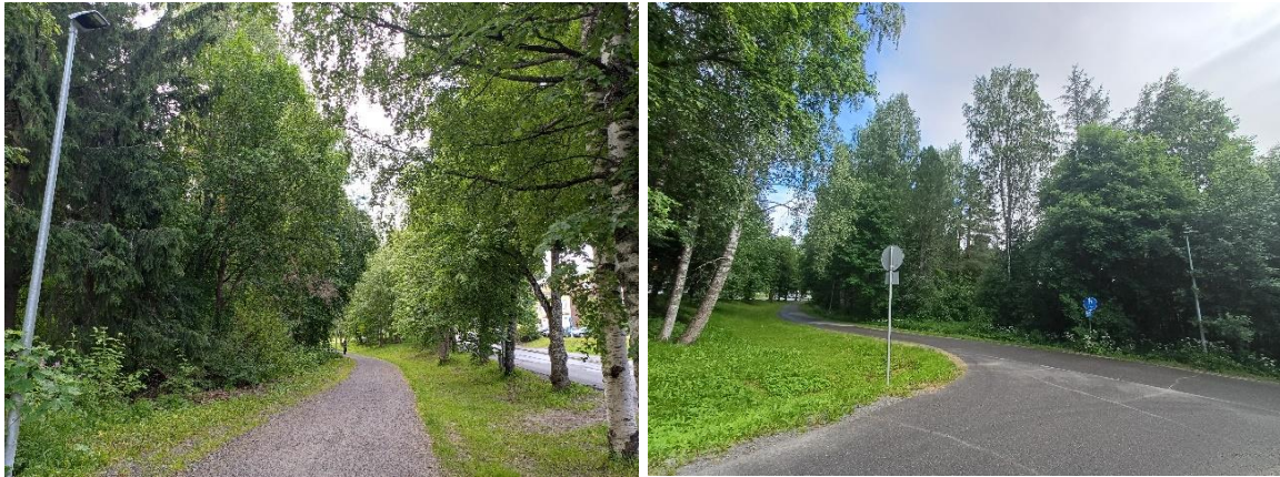
Kuva 4 Kevyen liikenteen väylän näkymiä rautatieaseman risteyksestä etelään ja kevyen liikenteen risteyskohdasta rautatieasemaa kohti
