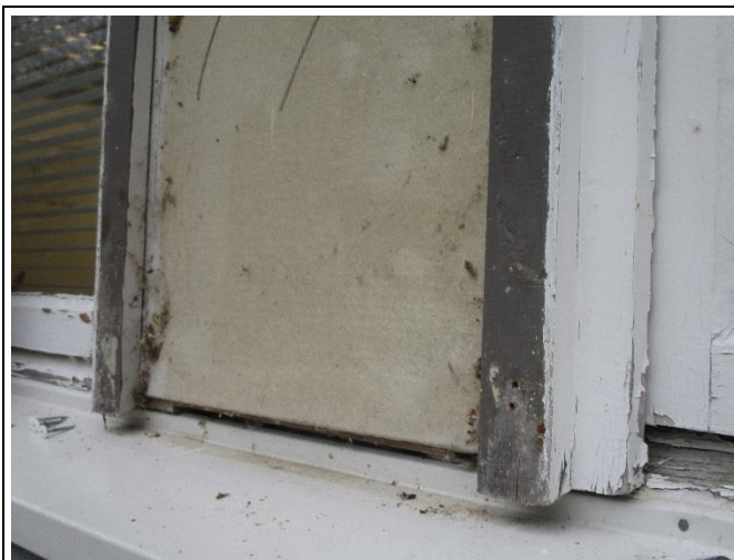
Kuva 15.9 Ikkunaliittymä luokkatilan 106 kohdalla
