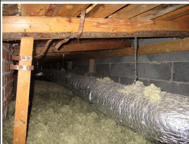
Kuva 12.5 Eristettyjä putkia yläpohjatilassa
