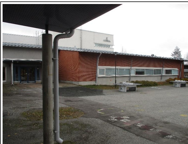
Kuva 6.4 1996 rakennetulla osalla kattovedet ohjataan rakennuksen vierelle
