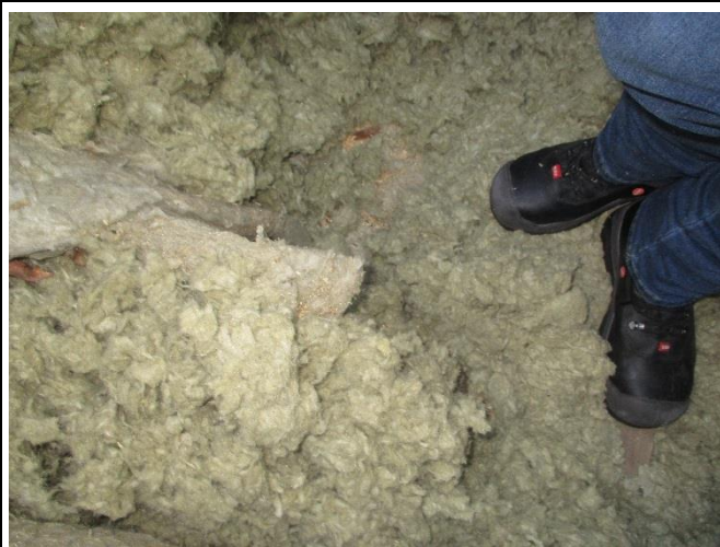
Kuva 12.3 Puhallusvillan alla on vanha purueriste
