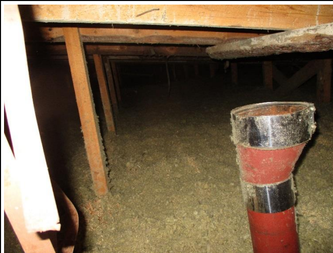
Kuva 12.4 Yläpohjassa on viemäriputki
