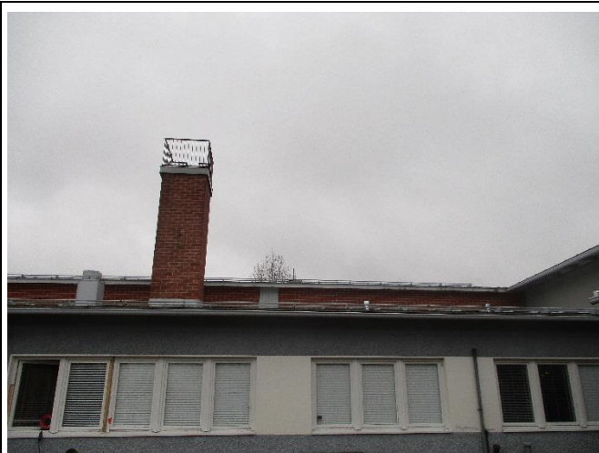
Kuva 12.1 Vanhimman osan vesikatto opettajanhuoneen kohdalta
