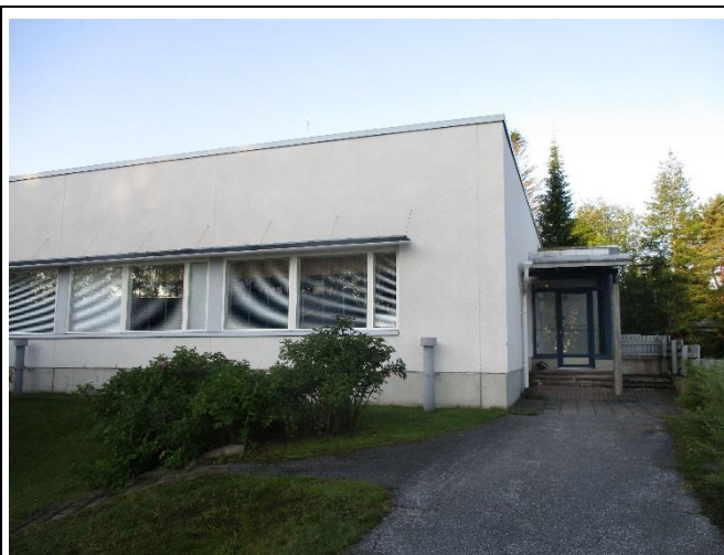
Kuva 6.3 2000 rakennetulla osalla kattovedet ohjataan kattokaivoihin
