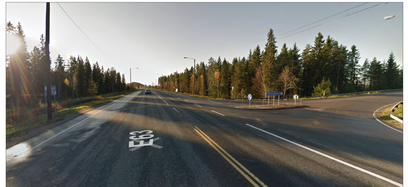
Kuva 3. Nykyinen Kinnulanlahdentien liittymä suunnittelualan pohjoispäässä, kuvan suunta etelään. Kuvan lähde Google maps
