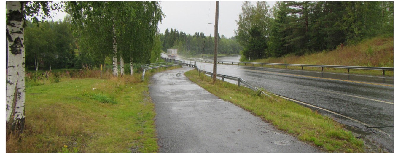
Kuva 2. Nykyinen valtatielinjaus ylittää Pitkäjärven Pulasten kohdalla. Valokuva © A. Soisalo
