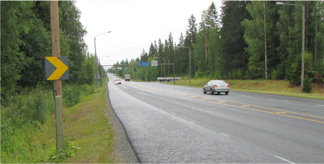
Nykyiseltä valtatieltä 5 on Pieni-Ahmon kohdalla yhteys etelän suunnasta Viitosen (Mt 559) liittymän kautta Radantaus teollisuusalueelle. Valtatien poikkileikkaus muuttuu moottoritiepoikkileikkaukseksi ja liittymä jää jatkossa vain erikoiskuljetusten käyttöön.
