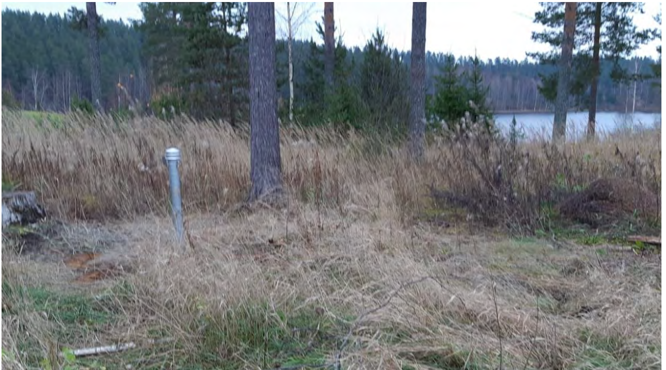
Kuva 6. Havaintoputki 302_21 asennettuna Tarinaharjun Golf-kentän alueella. Kuva GTK.
