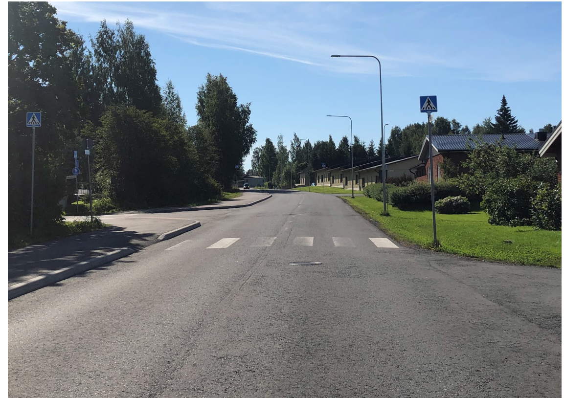
Kuva 24. Lapinlahdella (kuten monissa muissakin Kuopion seudun taajamissa) on suojateitä, jotka liittyvät suoraan sivuojaan tai nurmialueelle. Kuva Alapintieltä (kuva: Sitowise Oy).
