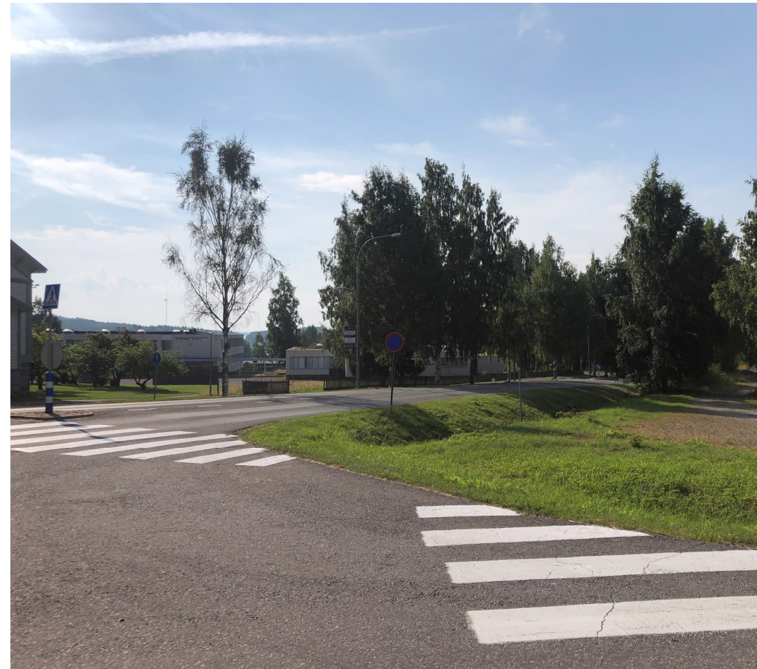
Kuva 35. Leppävirralla (kuten monissa muissakin Kuopion seudun taajamissa) on suojateitä, jotka liittyvät suoraan sivuojaan tai nurmialueelle. Kuva Leppävirrantieltä (kuva: Sitowise Oy).
